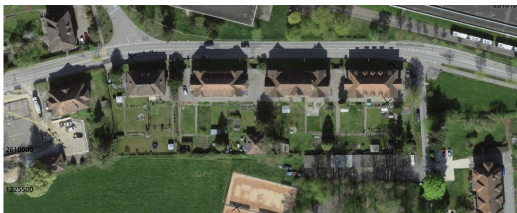
Abbildung 120: Luftbild der Wohnhäuser an der Derendingenstrasse (geo.so.ch 15.10.2025)
